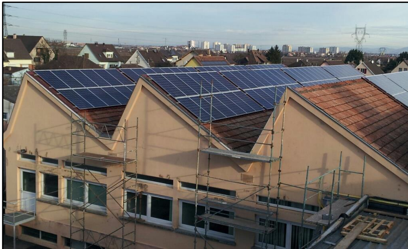
Dächer von Industriegebäuden in Colmar
